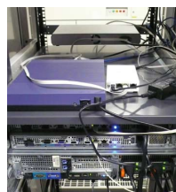
堅牢・省スペースの筐体はデータセンタのルータ横のデッドスペースに設置
