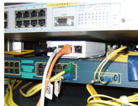
堅牢な小型の筐体を生かし、サーバー上のデッドスペースに設置されるOpenBlockS 600
